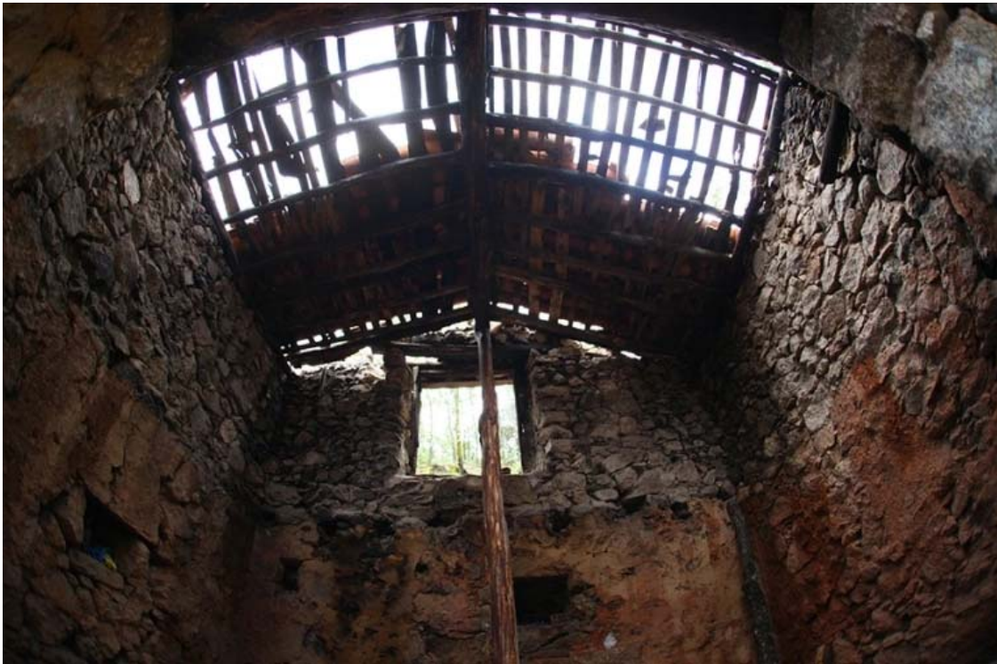
2017. Rehabilitación de secadero en la sierra de Tormantos (La Vera)
