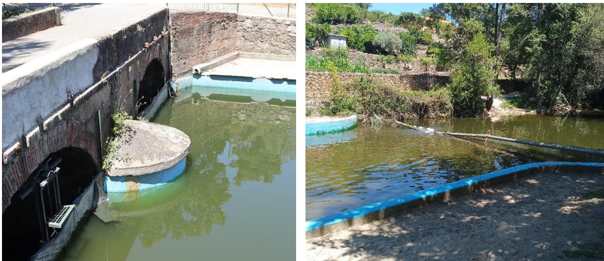
Figura 69. Nivel del agua en la piscina Garganta de Gualtaminos
