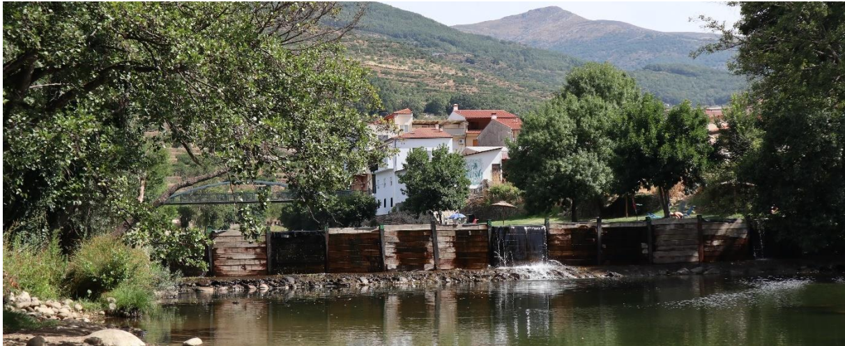
Figura 36. Cierre del embalsamiento de la zona de baño de El Vaho
