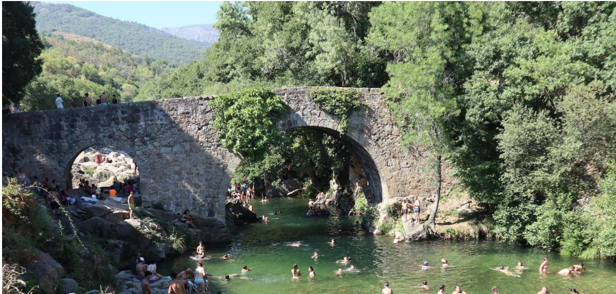
Figura 57. Zona de baño Puente de Cuartos
