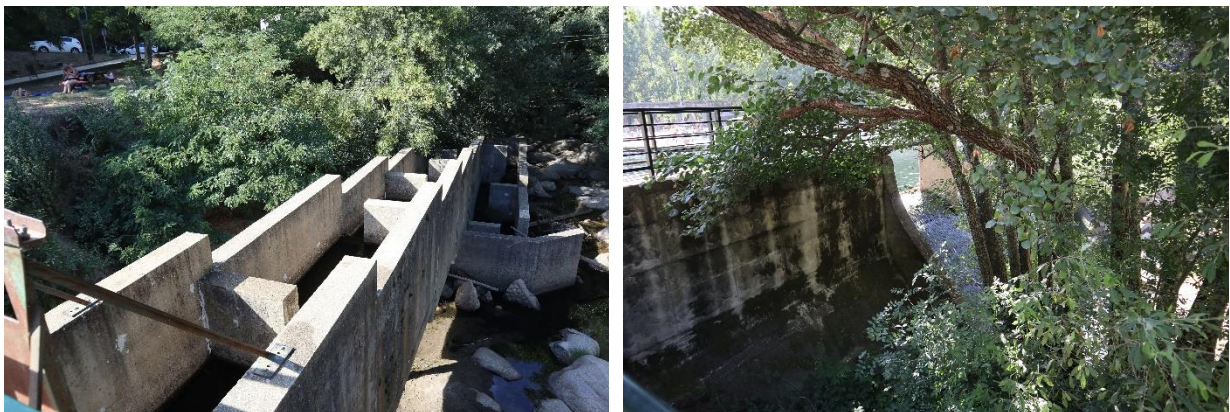
Figura 51. Rampa para peces y pasos de agua de la presa de la zona de baño de El Lago
