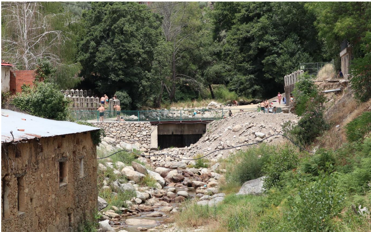
Figura 48. Cierre del embalsamiento de la zona de baño de San Gregorio Fuente: Elaboración propia en trabajo de campo. Julio de 2022
