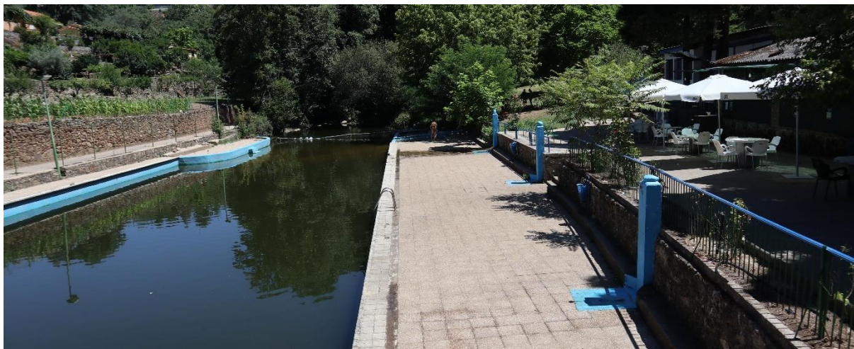
Figura 70. Nivel inferior de la piscina municipal de la zona de baño de Garganta de Gualtamínos
