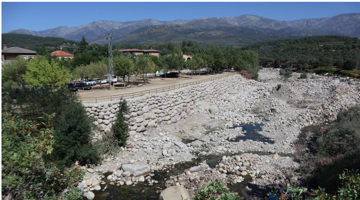
Figura 64. Muro de contención aguas arriba de la Piscina del Puente de Alardos
